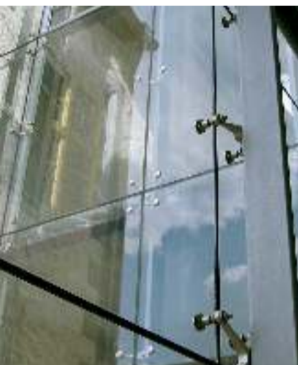
Nach DIN 18008-3 – eine Fassade mit Punkthaltern
