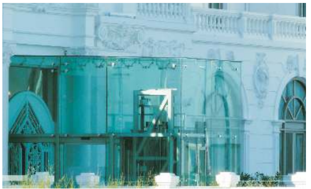
Glaskonstruktionen am Flughafen im spanischen Vigo, im Eingangsportal im Casino von Saragossa und das Umluftsystem im Einkaufszentrum von Marineda City sind mit zertifizierten Haltesystemen von SWS befestigt.
