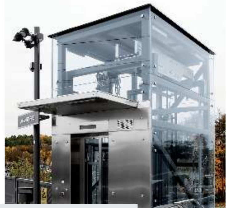
Nach DIN 18008-3 – die punktgehaltene Fassade eines Fahrstuhl-Eingangsbereichs in Stockholm
